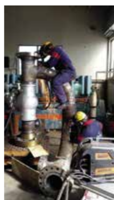
Holutoppur í smíðum í beistareykjavirkjun.
